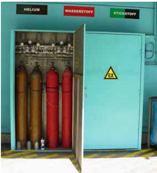
Bild 4: Zentrale Gasversorgung
