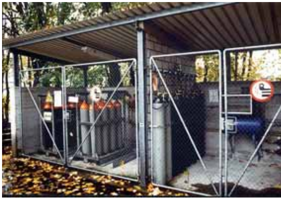
Bild 20: Durch eine Wand getrennte Aufstellung
