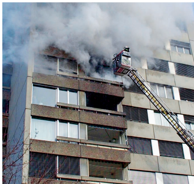
L'intervention des sapeurs-pompiers est limitée par la hauteur d'action des échelles et nacelles.
