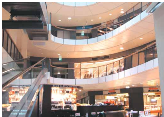
Pendant les travaux de transformation du Shoppyland, la protection incendie devait être garantie en tout temps.
