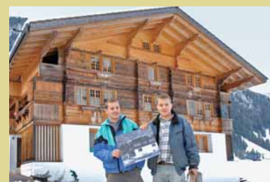
Après le passage de Lothar, les frères Schneider ont dû recouvrir le toit de l'« alte Becki » à Kandergrund – la plus belle maison de la vallée de la Kander.
