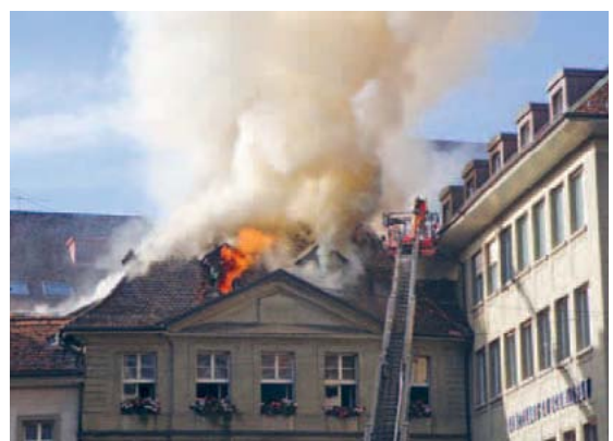
Les gros sinistres tels que l'incendie du Restaurant Räblus dans la vieille ville de Berne (notre illustration) ont entraîné des dommages causés par des incendies supérieurs à la moyenne en 2010.
