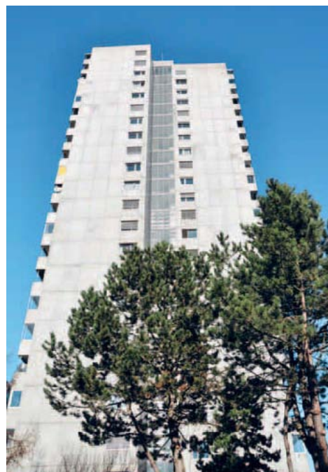
Dans le cadre de la surveillance du feu, les experts de la protection incendie de l'AIB ont contrôlé en 2010 plus de 600 bâtiments élevés dans le canton. L'immeuble sis à la Jupiterstrasse 1 à Berne en fait partie.
