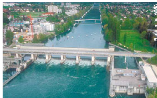
La station de régulation à Port influe sur les niveaux des eaux des trois lacs du pied du Jura – et partant, sur le cours de l'Aar.
