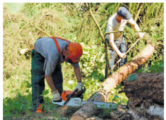
Père et fils découpent le bois d'un arbre qu'il a fallu abattre sur le terrain à construire.
