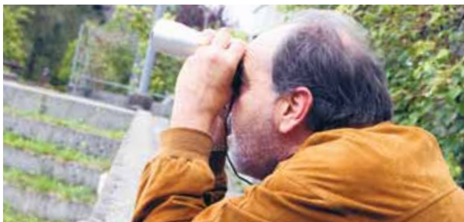
Avec ses jumelles, Joe Wyss examine le toit à la recherche d'impacts de grêle.
