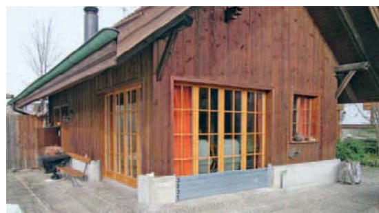
Dank der Objektschutzmassnahmen, die im Nachgang des heftigen Unwetters von 2007 in Kleindietwil erstellt wurden, konnte im August 2010 Schlimmeres verhindert werden.
