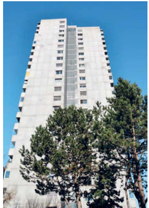
Im Rahmen der Feuerschau haben Brandschutzexperten der GVB 2010 über 600 Hochhäuser im Kanton kontrolliert. Das Gebäude an der Jupiterstrasse 1 in Bern ist eines davon.
