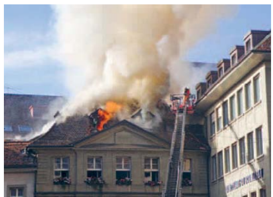
Grossere Ereignisse wie der Brand des Restaurants Räblus in der Altstadt von Bern (im Bild) führten zu überdurchschnittlich hohen Feuerschäden im Jahr 2010.
