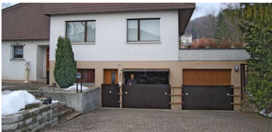
Nach zwei Hochwassern schützt Walter Laubscher sein Haus mit einer selbst gebauten Wassersperre.
