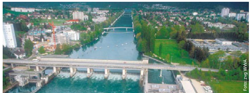
Durch das Regulierwerk in Port werden die Wasserstände aller drei Jurarandseen beeinflusst – und damit auch der Aareabfluss.
