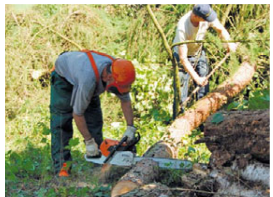
Vater und Sohn zerlegen das Holz eines Baumes, der auf dem Bauland stand.
