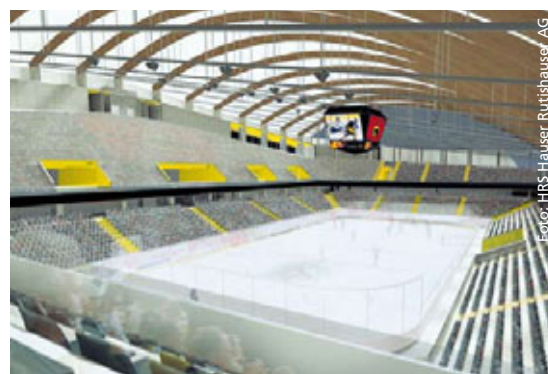
Die Stehplatztribüne der PostFinance-Arena mit den neuen «Mundlöcher»-Fluchtwegen.
