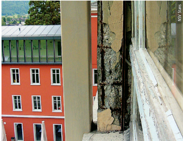
Eine häufige Ursache für den Einsturz von Gebäuden bei Erdbeben bildet das Schubversagen von sogenannten kurzen Stützen. Mit einer Stahlverstärkung wurde in diesem Beispiel der Bau gestützt.
