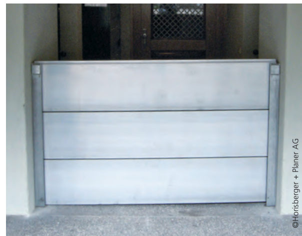
Dank GVB-Motivationsfinanzierung: Wassersperre im Matte-Quartier Bern verhindert neue Überflutung.
