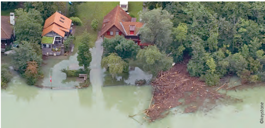
Der Bielersee überflutete während der Unwetter ganze Wohngebiete.
