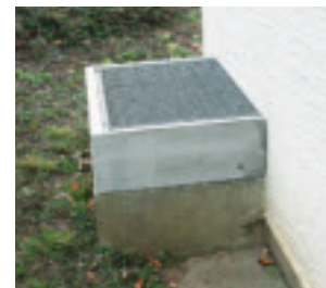
Hochwasser-Rückhaltesperren in Türen oder erhöhte Lichtschächte sind einfache, aber wirksame Schutzmassnahmen vor Hochwasser.
