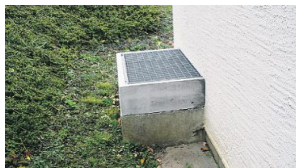
Höher gelegte Lichtschächte schützen vor Wasserschäden.
