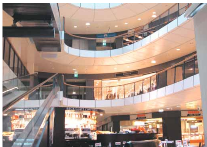
Auch während des Umbaus im Shopyland muss der Brandschutz jederzeit gewährleistet sein.
