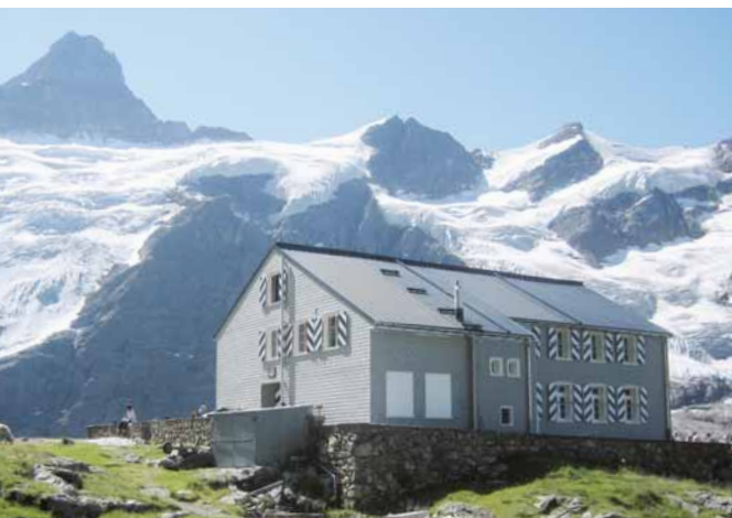
Auch die Glectsteinhütte oberhalb Grindelwalds mitten im Hochgebirge weist einen minimalen Brandschutzstandard auf.
