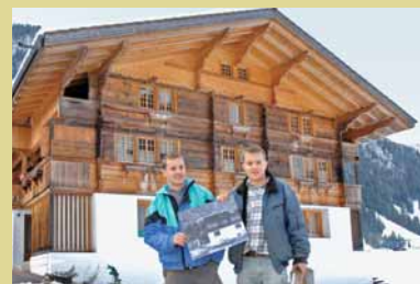
Das Dach der «alten Becki» in Kandergrund – des schönsten Hauses des Kandertals – mussten die Gebrüder Schneider nach dem Lothar erneuern.
